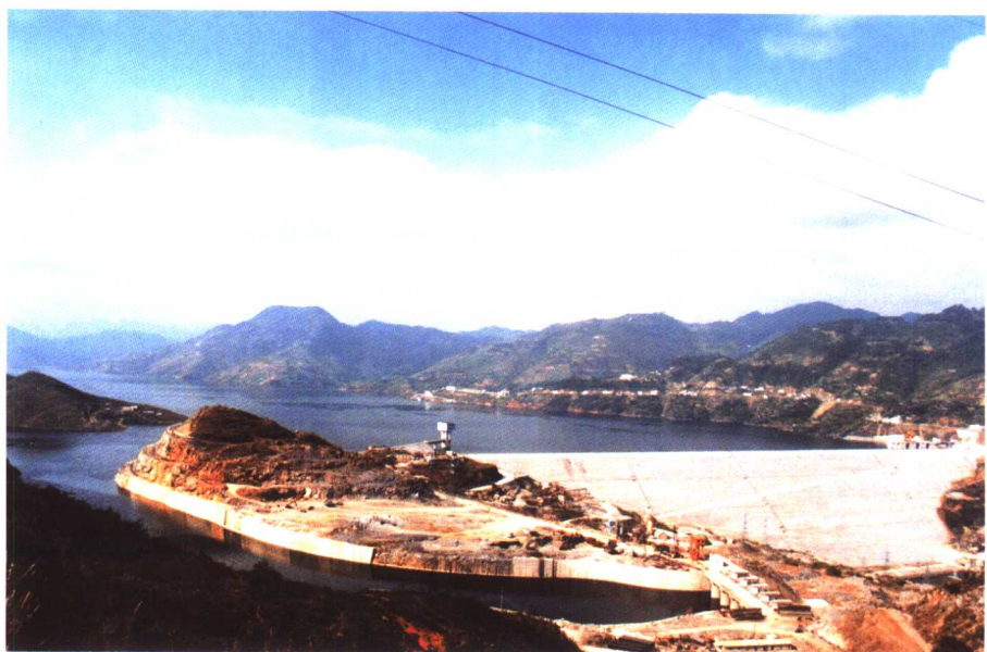
洪家渡水电站
