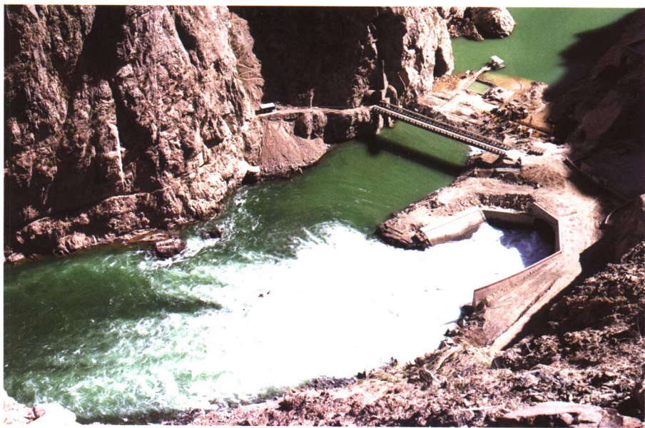
拉西瓦水电站导流洞
