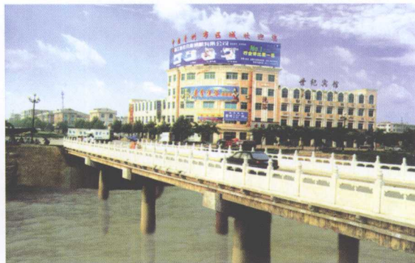
新世纪商城南门大桥
