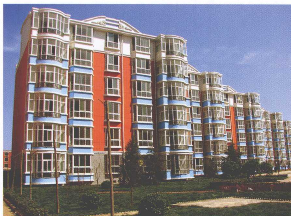
帝华集团 晋州龙头花园在建工程
