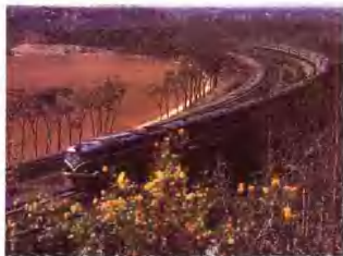
开发银行贷款支持的神农铁路建设
