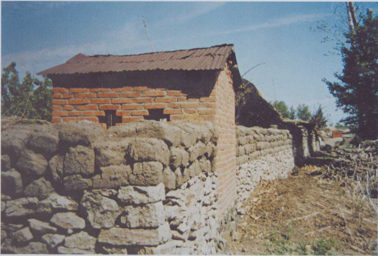
富含有机质的均腐土 表层用以构建围墙 黑龙江齐齐哈尔 (龚子同 摄)
