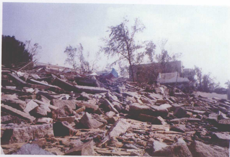
2000年2010号台风,赖源乡河祠村房屋倒塌损坏800多间,死亡6人。武警战士在寻找幸存者
