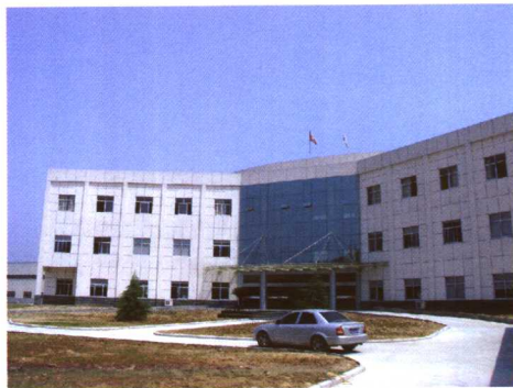
▲ 松阳工业园区浙江虎牌电缆公司大楼
