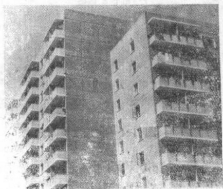
图 1-7 带水平分格缝的预制混凝土墙板
