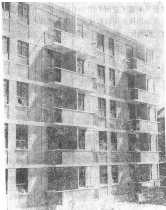
图 1-6 北京某加气混凝土条板住宅
