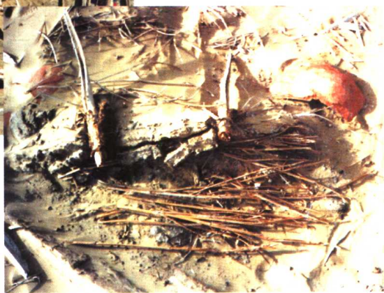
图 3 倒塌的芦苇墙
