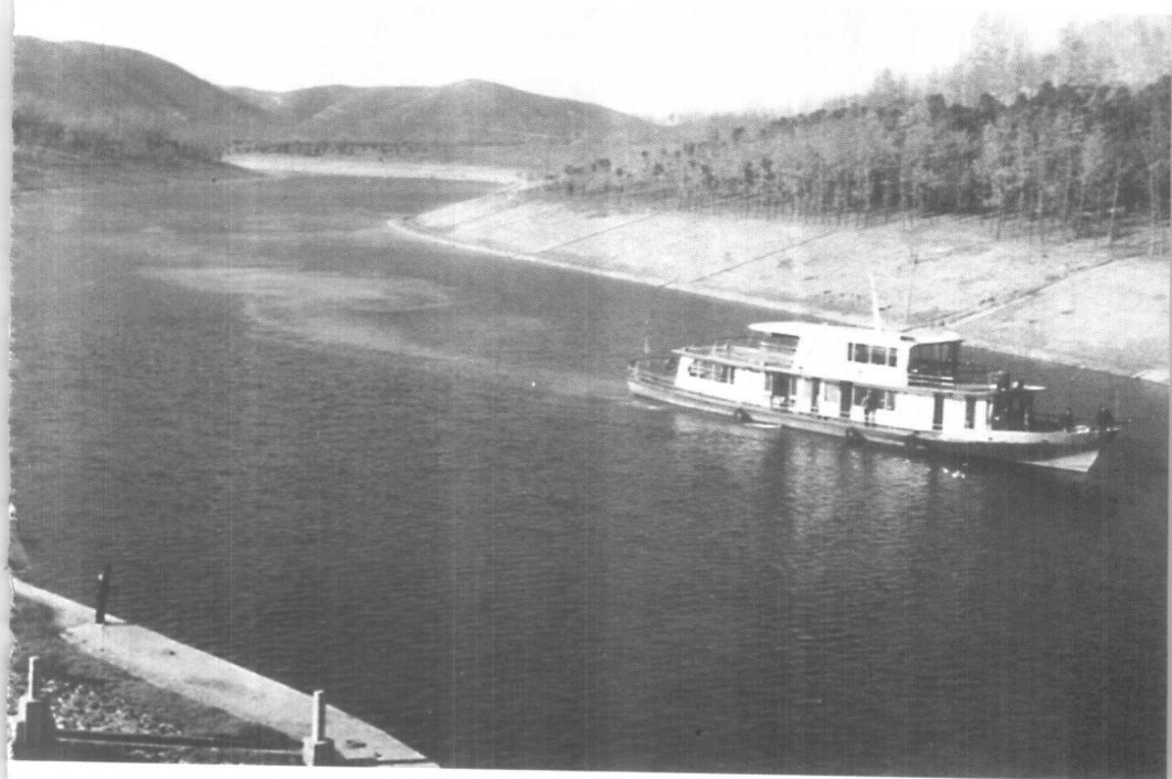
南水北调中线工程陶岔闸引水渠道
