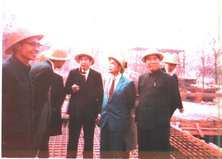
北京市副市长韩伯平同志、香港知名人士霍英东先生视察北京饭店扩建工程贵宾楼工地。
