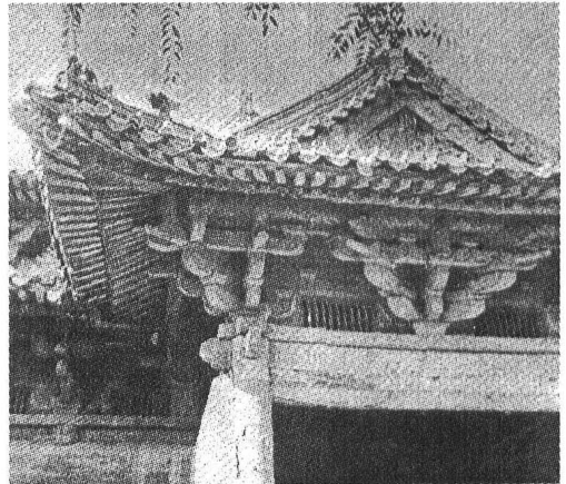
图4 河北正定隆兴寺摩尼殿抱厦一角
