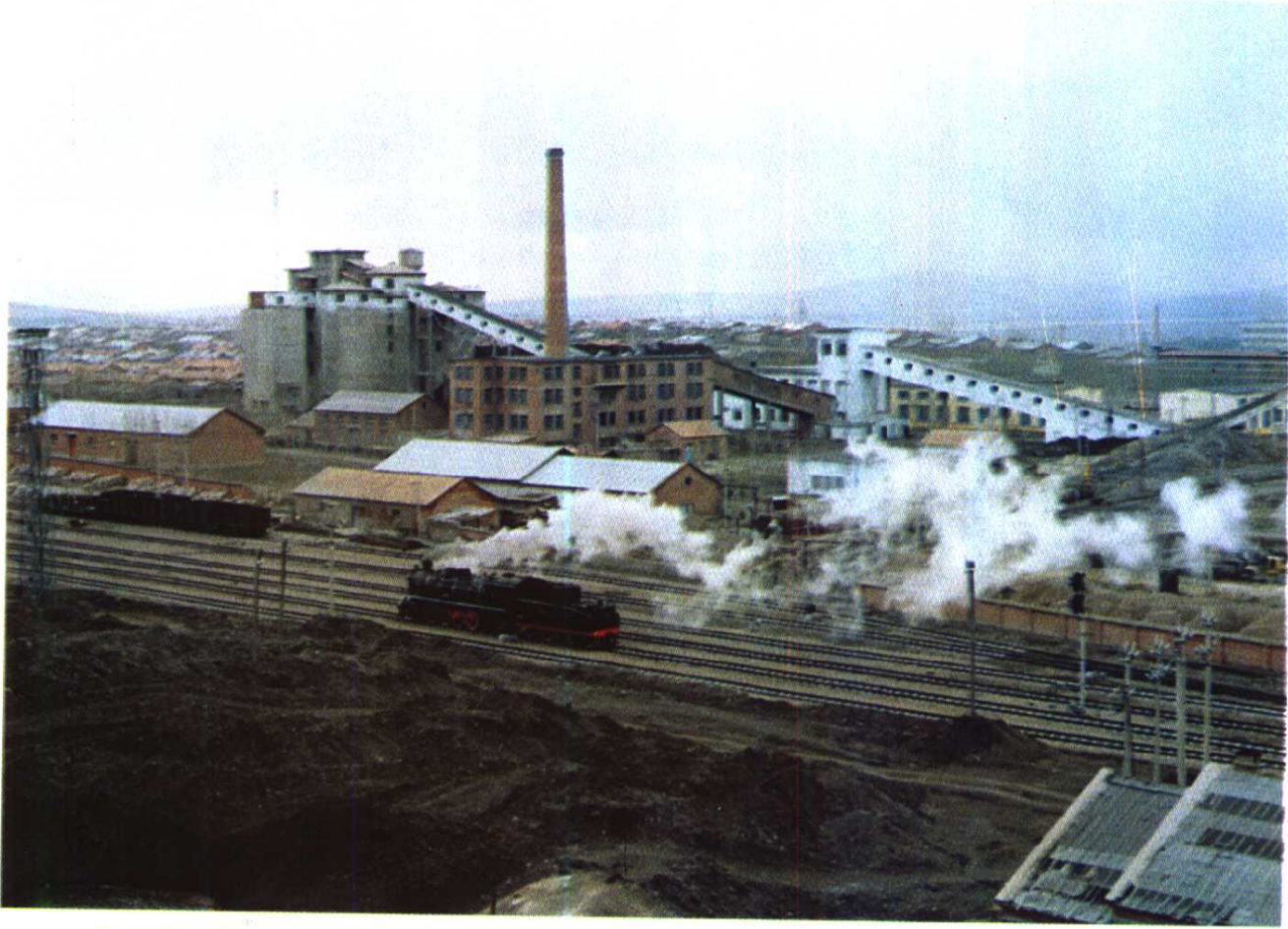
大雁矿务局二矿全景
