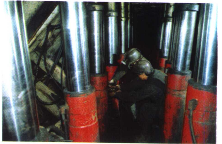
乌达矿务局黄白茨矿综采工作面正在移柱
