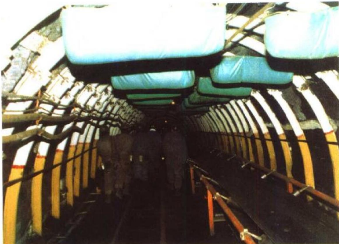
大雁矿务局一矿井下防火水帘
