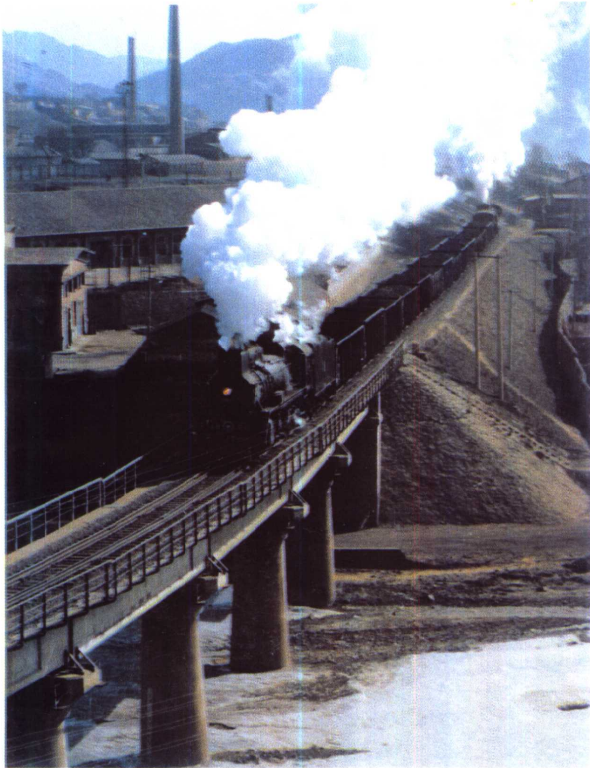
包头矿务局焦煤源源不断外运
