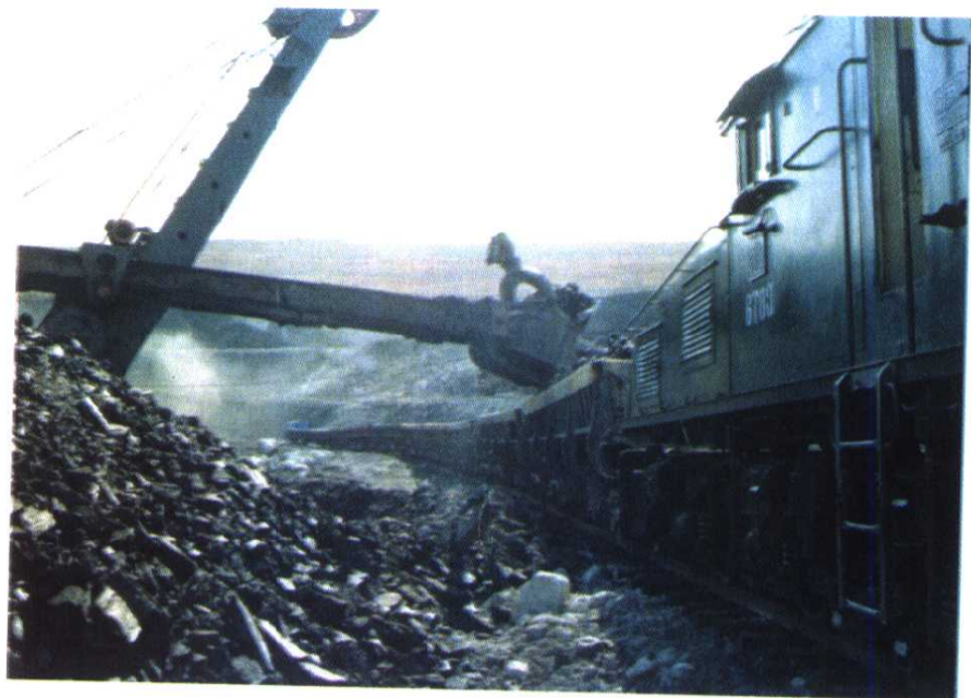
平庄矿务局西露天矿采剥现场
