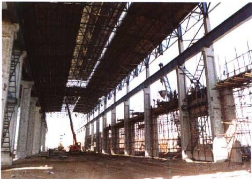
准格尔煤田在建设中
