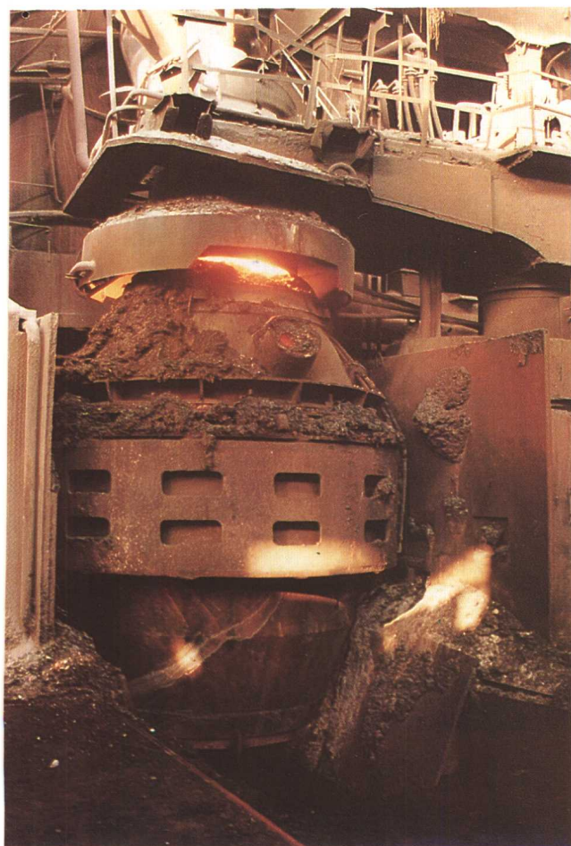
6 吨氧气顶吹炼钢电炉（兰州钢厂）
