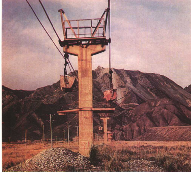
全长 11.7 千米的西沟石灰石矿 架空运输索道（酒泉钢铁公司）
