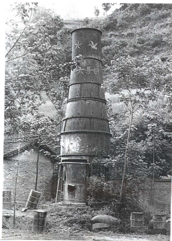
徽县小河铁厂 1958 年建设的小高炉
