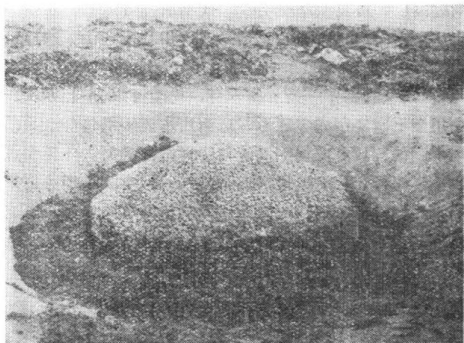
图六 已安放好的“无砂滤罩” 罩高30cm 外径100cm 厚25cm
