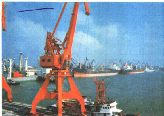
湛江港新建的深水泊位码头
