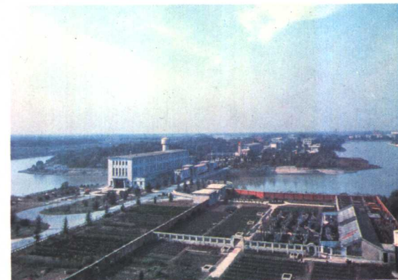
都抽水站全景 我国南水北调东线工程的起点——江
