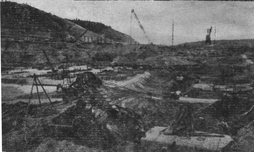
左：古比雪夫水電站的基坑掘土工作快要完工了，共挖出了六百萬立方公尺的土。它比伏爾加河的水平面還低下二十五公尺，共
