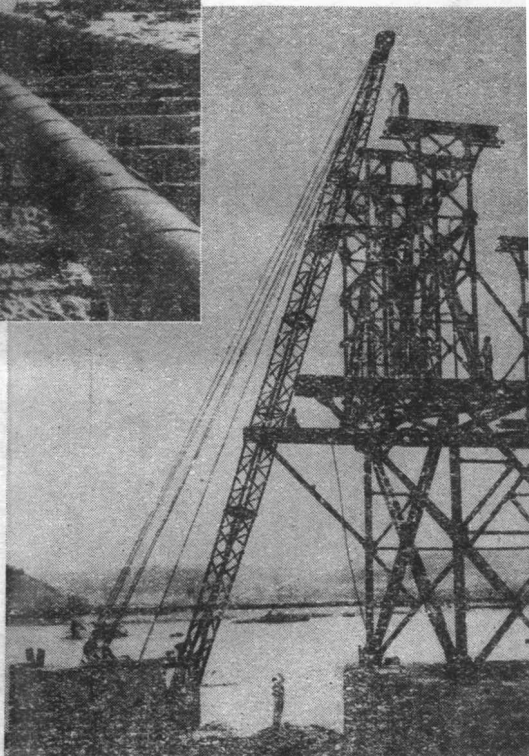
上：在古比雪夫水電站建築的基槽下面鋪設地下管。管長約達一公里。
