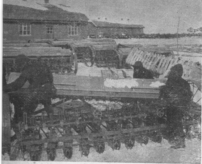
7. 工人們正在安裝蘇聯最新式的四十八行播種機。
