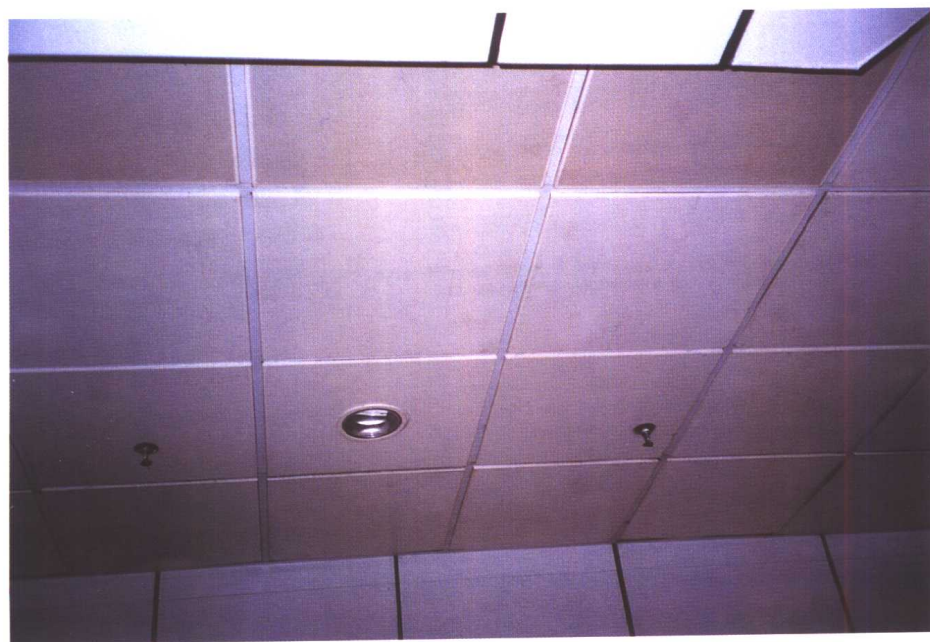
彩图 1.07 金属方板明式(明架) 吊顶
