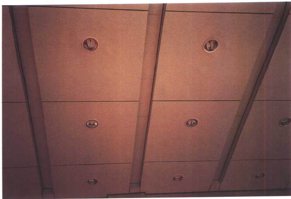
彩图 1.06 金属方板暗式(嵌装) 吊顶
