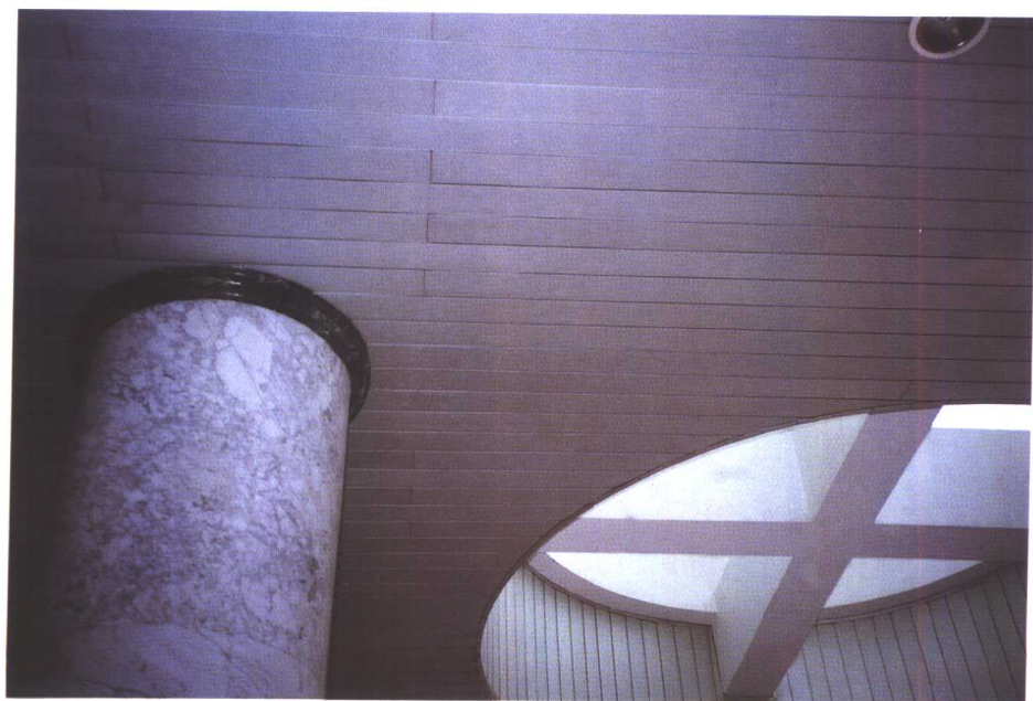
彩图 1.09 金属条形板吊顶饰面工程示例 金属条形板饰面与吊顶的装饰造型和谐处理而形成较为独特的空间环境效果
