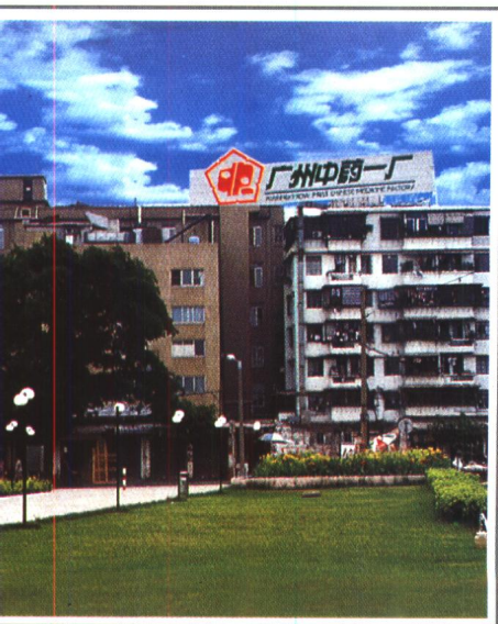
广州中药一厂生产厂区
