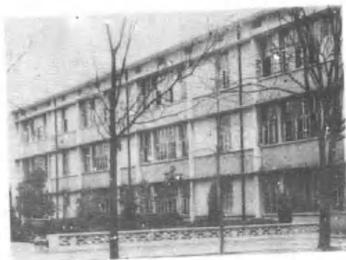
宽敞明亮的教学大楼
