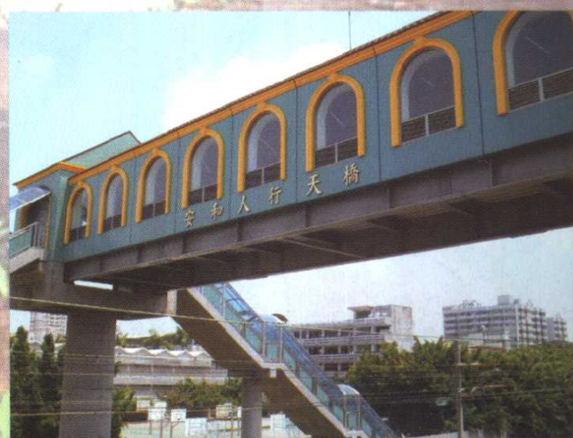
彰化市政府 彰化市曉陽路陸橋新建工程 GRC造型牆版
