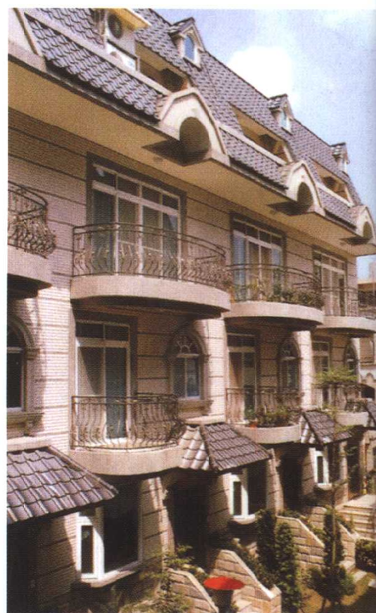
榮運建設股份有限公司 常春藤別墅(桃園縣平鎮市) GRC老虎窗、飾塊
