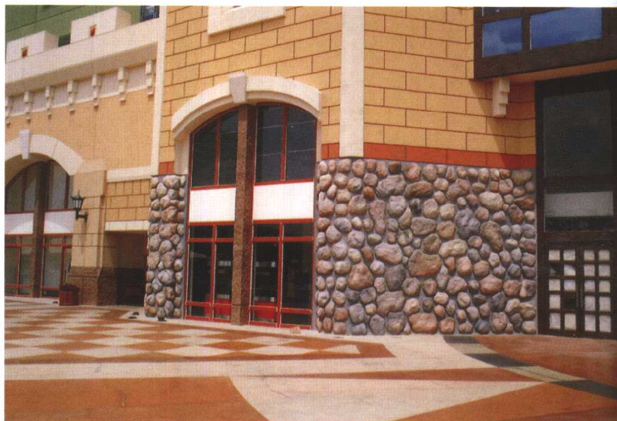
今日美術建築股份有限公司 南崁台茂購物中心(桃園縣蘆竹鄉) GRC仿岩石牆版
