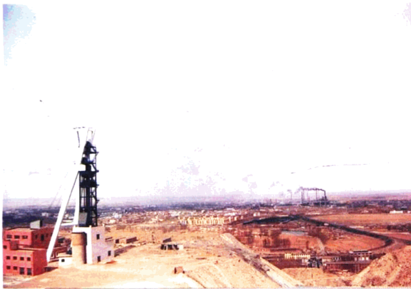
金川有色金属公司的二 矿区西主井 ( \phi 4.5\text{m} \times 4 绳, 3500kW 落地式摩擦 轮卷扬机)
