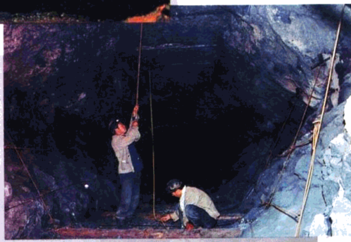
金川龙首矿的科技人员、工人在下向六角形进路胶结法采场中工作的情况
