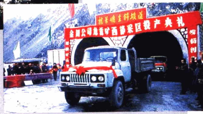
金川龙首矿的主斜坡道与西部采区（露天转井下开采）投产
