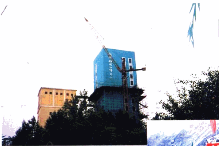
金川龙首矿的新 2 号主井及正在建设中的新 1 号主井
