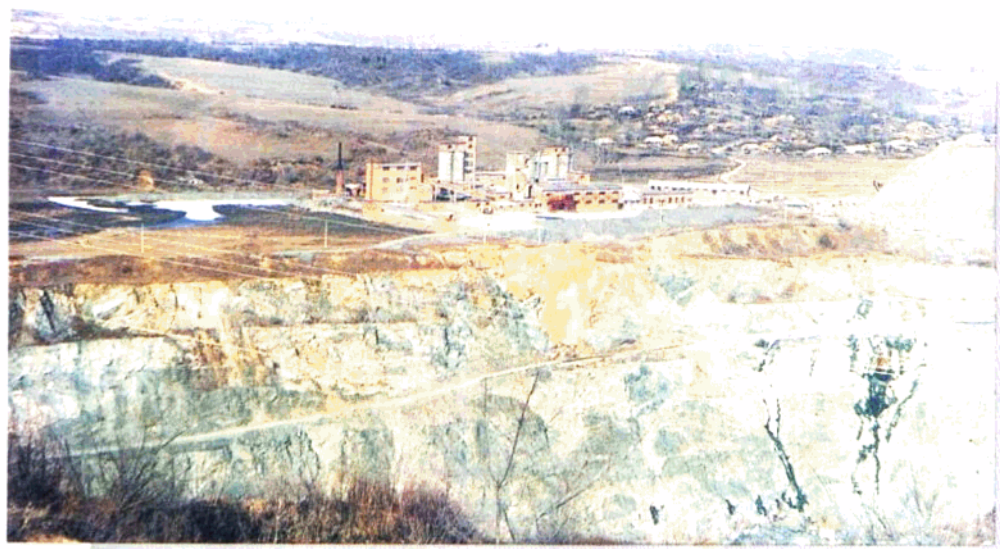
吉林磐石镍矿的富家矿露天采场上盘边坡和充填系统
