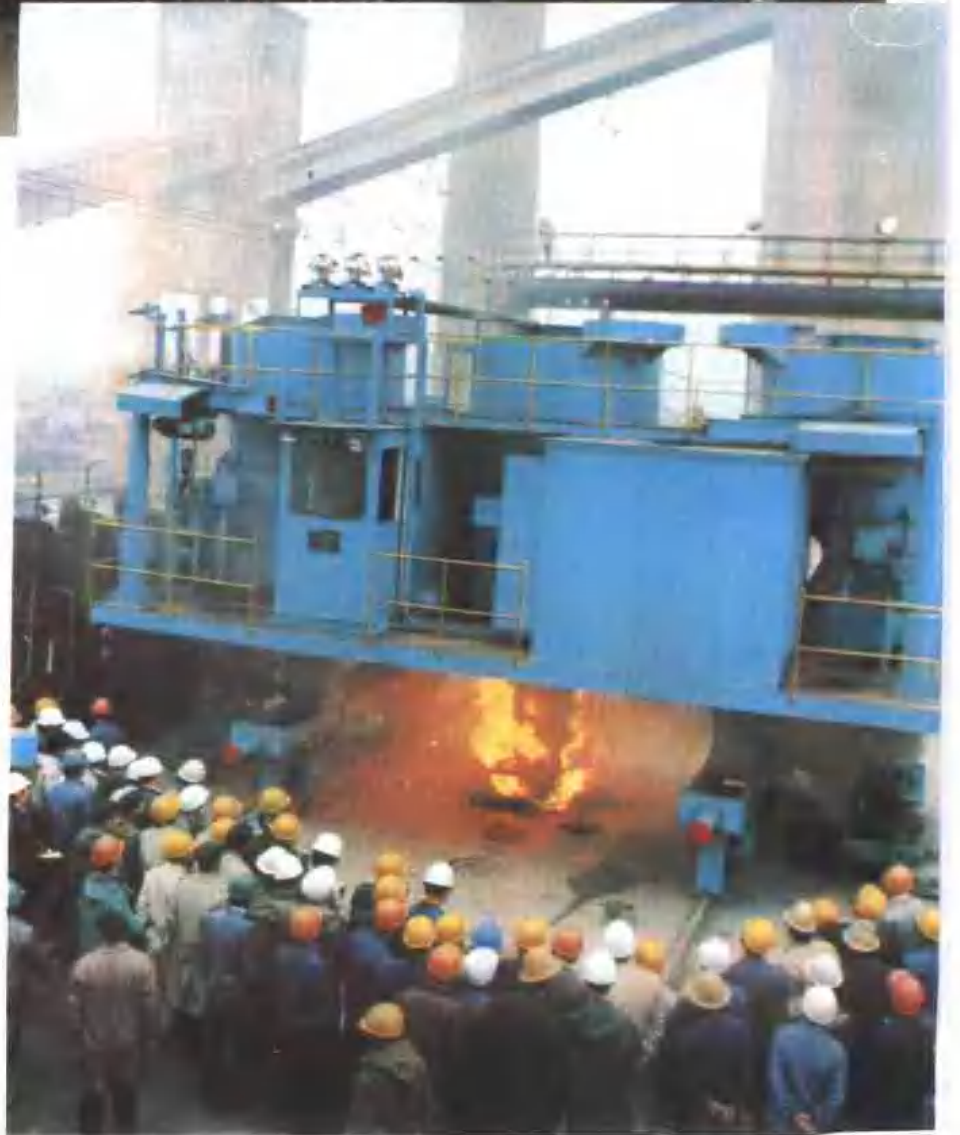
第二煤气厂焦炉装煤 试运转一次成功。
