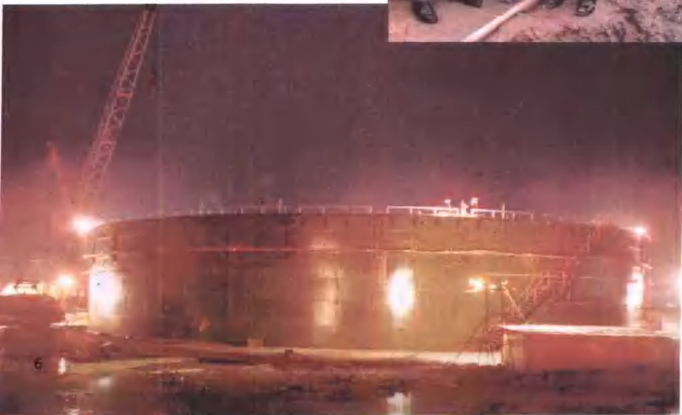
塘沽储配站正在紧张施工。
