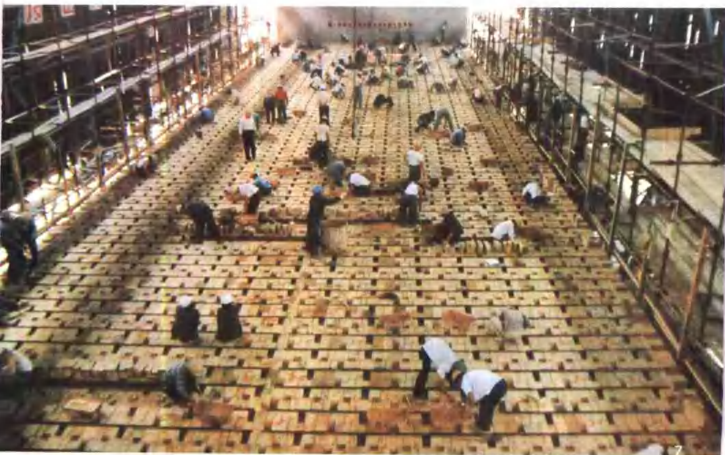
第二煤气厂焦炉筑炉施工。
