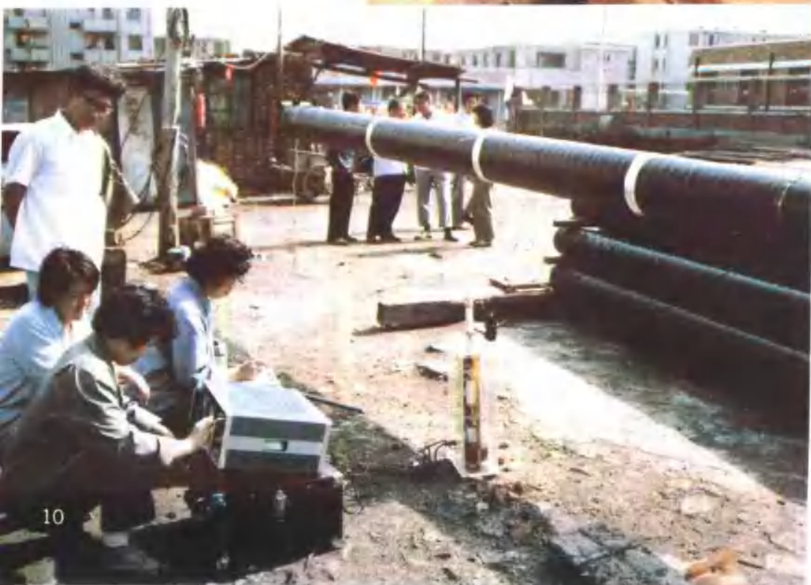
工程技术人员检验管材防腐质量。
