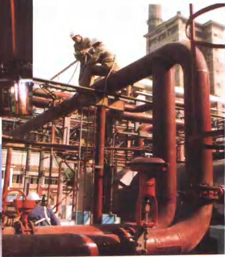
三法脱硫设备安装。
