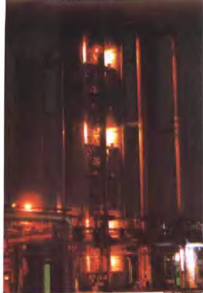
第二煤气厂硫铵塔。
