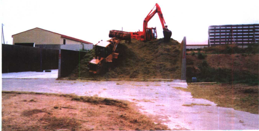
地面青贮原料的装填压实作业
