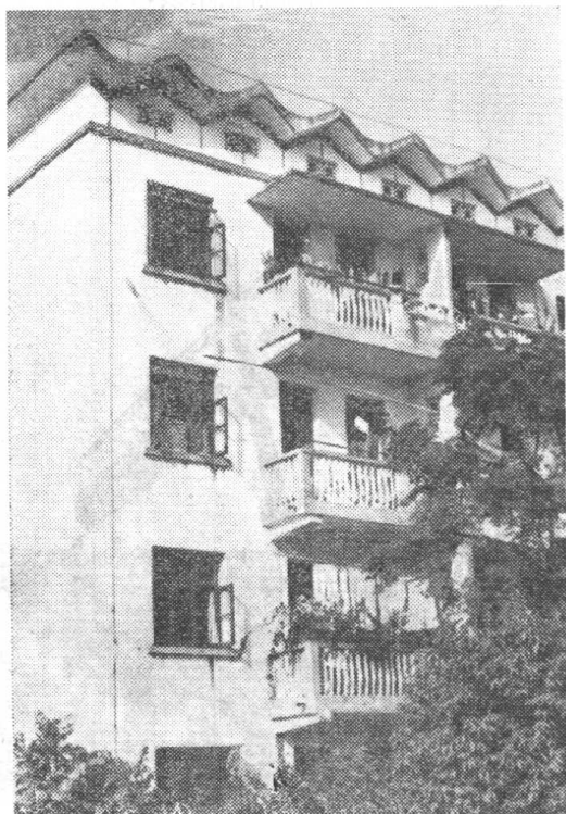
图 1-5 折板屋盖住宅建筑
