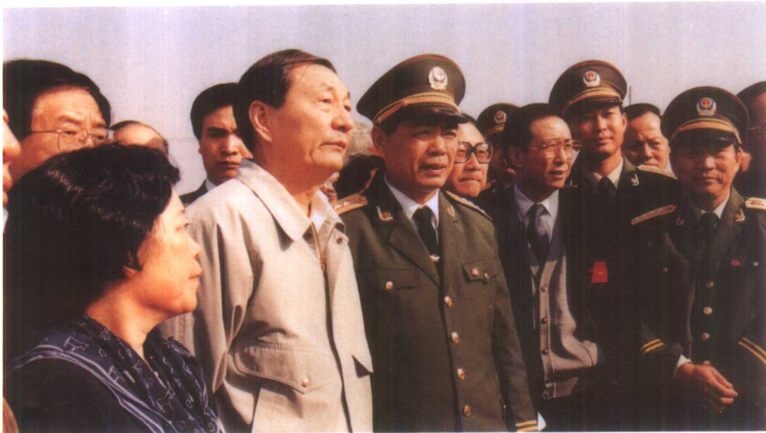
9. 1994年11月2日,朱镕基副总理到三峡工程永久船闸工地看望正在施工的武警水电部队 (廖德真 摄)
