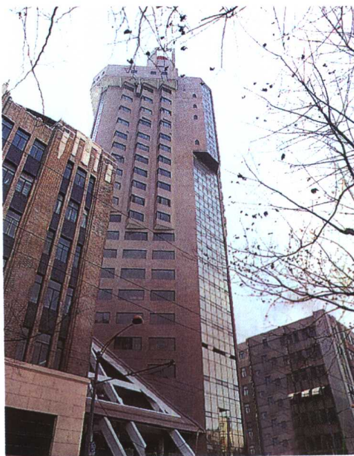
彩图 19 劈离砖建筑外墙装修效果图
