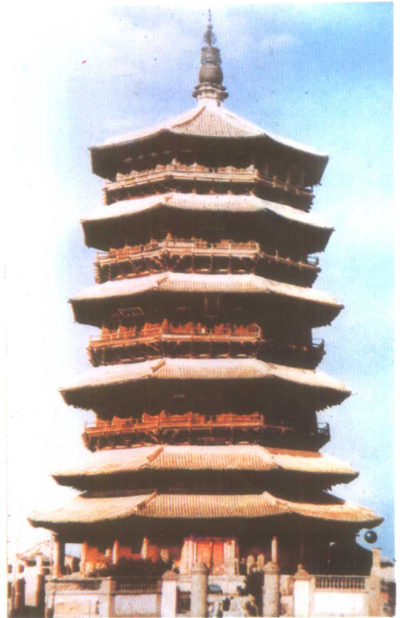
图1—9 山西应县木塔
