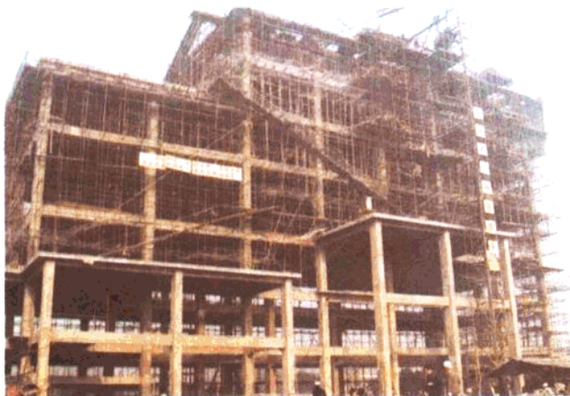
南京化学工业公司，全国最大的年产24万吨磷胺工程的主厂房在建设中。
