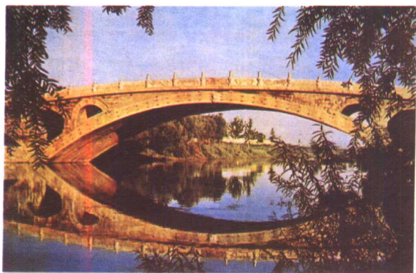
河北趙縣安濟橋 建於公元589—608年
