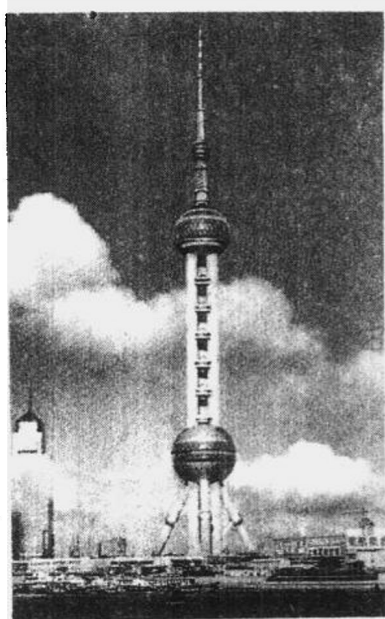
图 0-6 上海东方明珠广播电视塔
