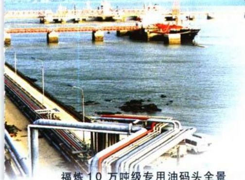
福炼10万吨级专用油码头全景
