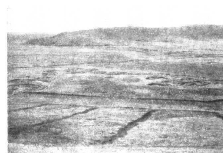
照片 31 龙日坝娃玛尔沟阶地沼泽中之排水工程
