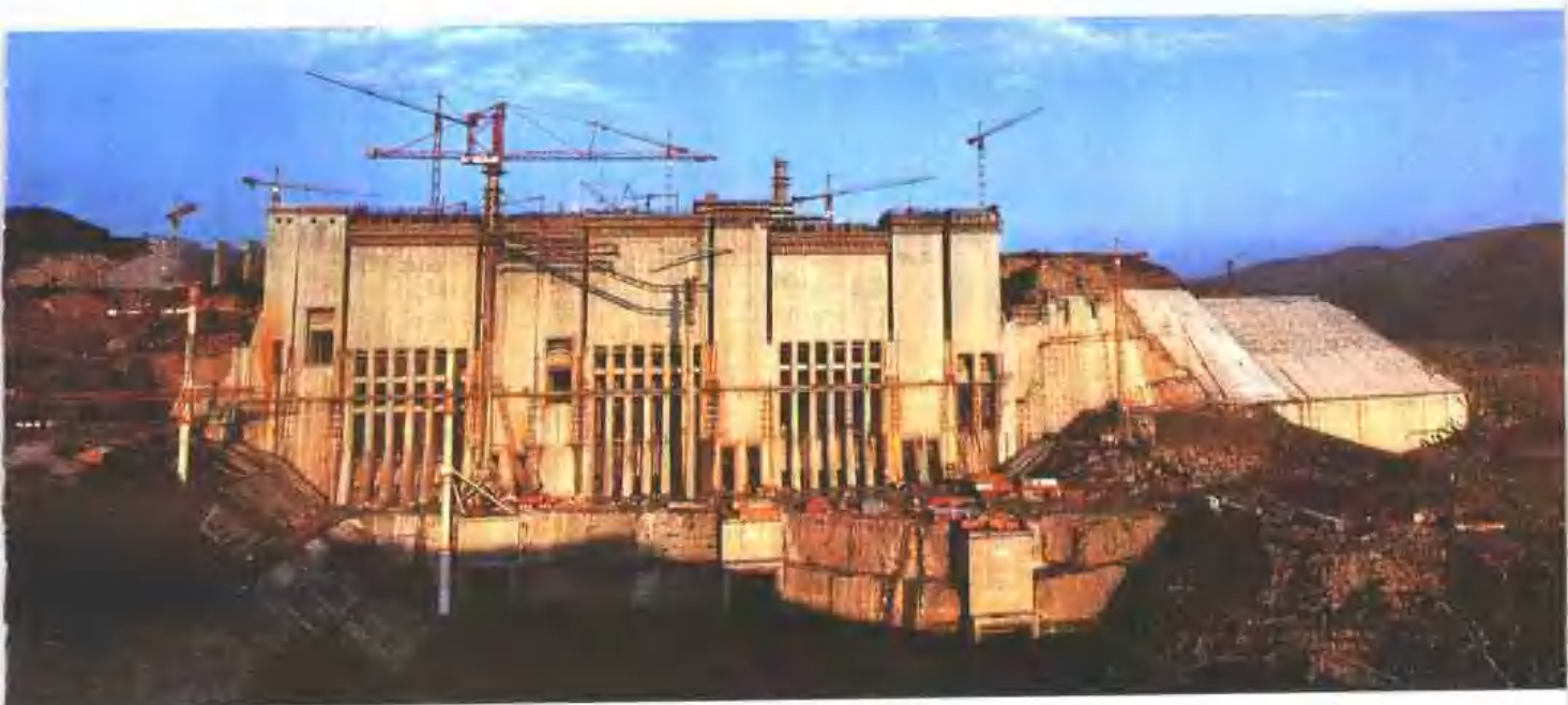
小浪底水利枢纽进水口全景
