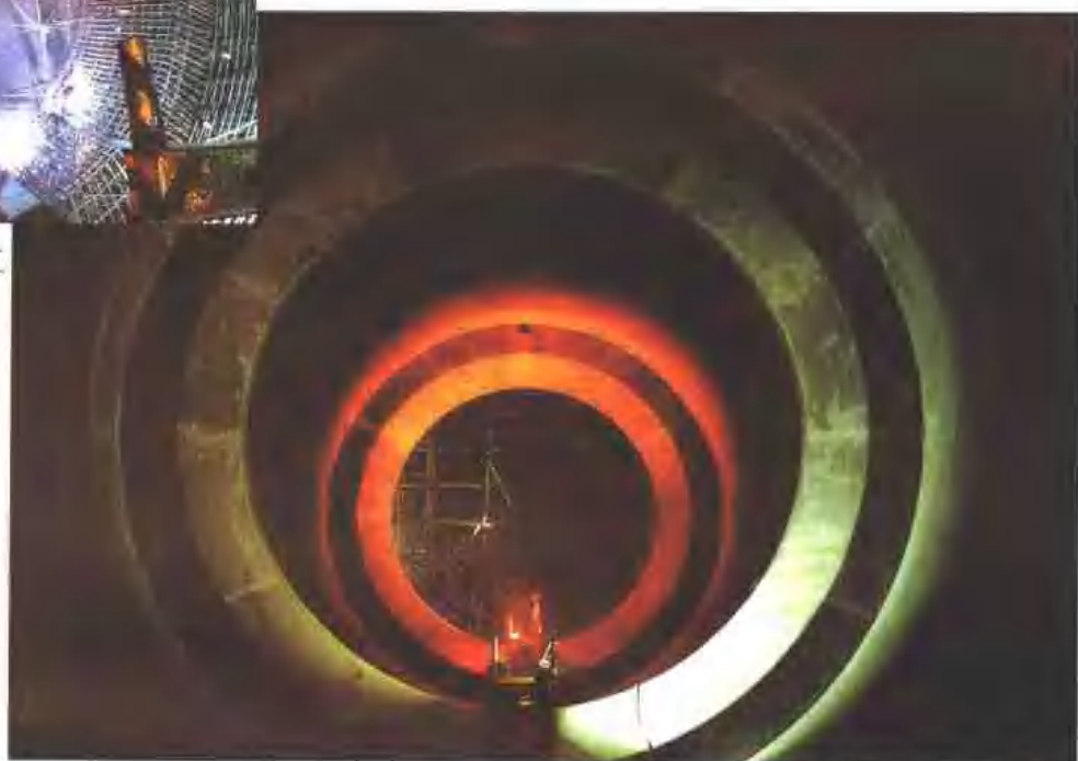
孔板消能泄洪洞
