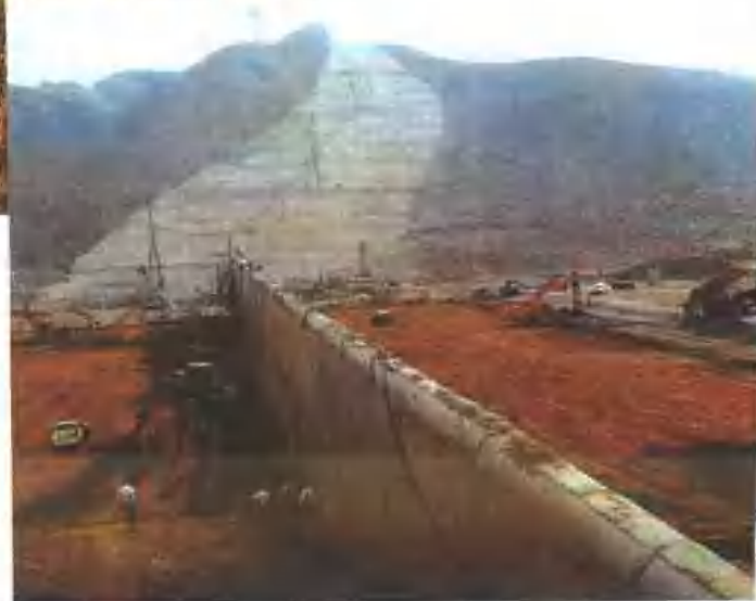
国内最深的大坝防渗墙
