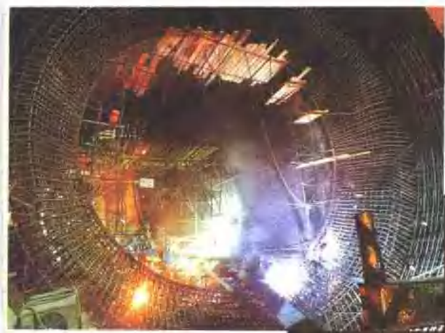
孔板消能泄洪洞的孔板环施工
