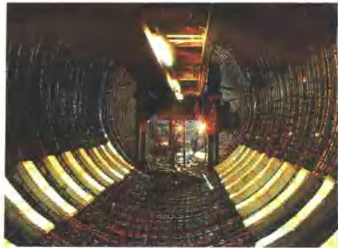
排沙洞后张法预应力混凝土施工
