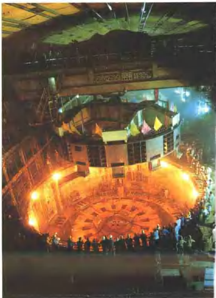
发电机组定子吊装
