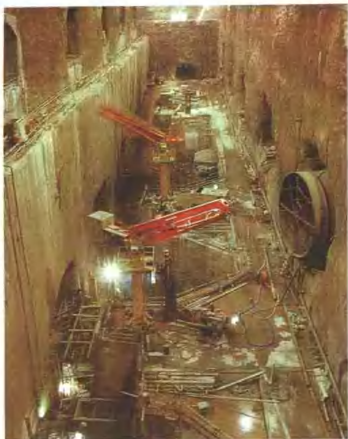
地下厂房施工现场
