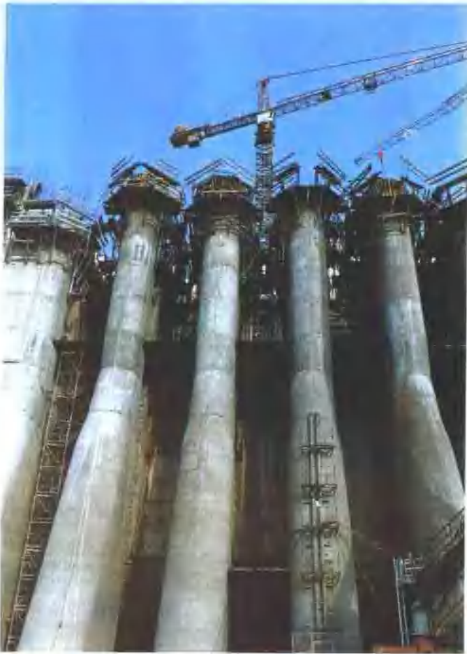
施工中的进水塔群
