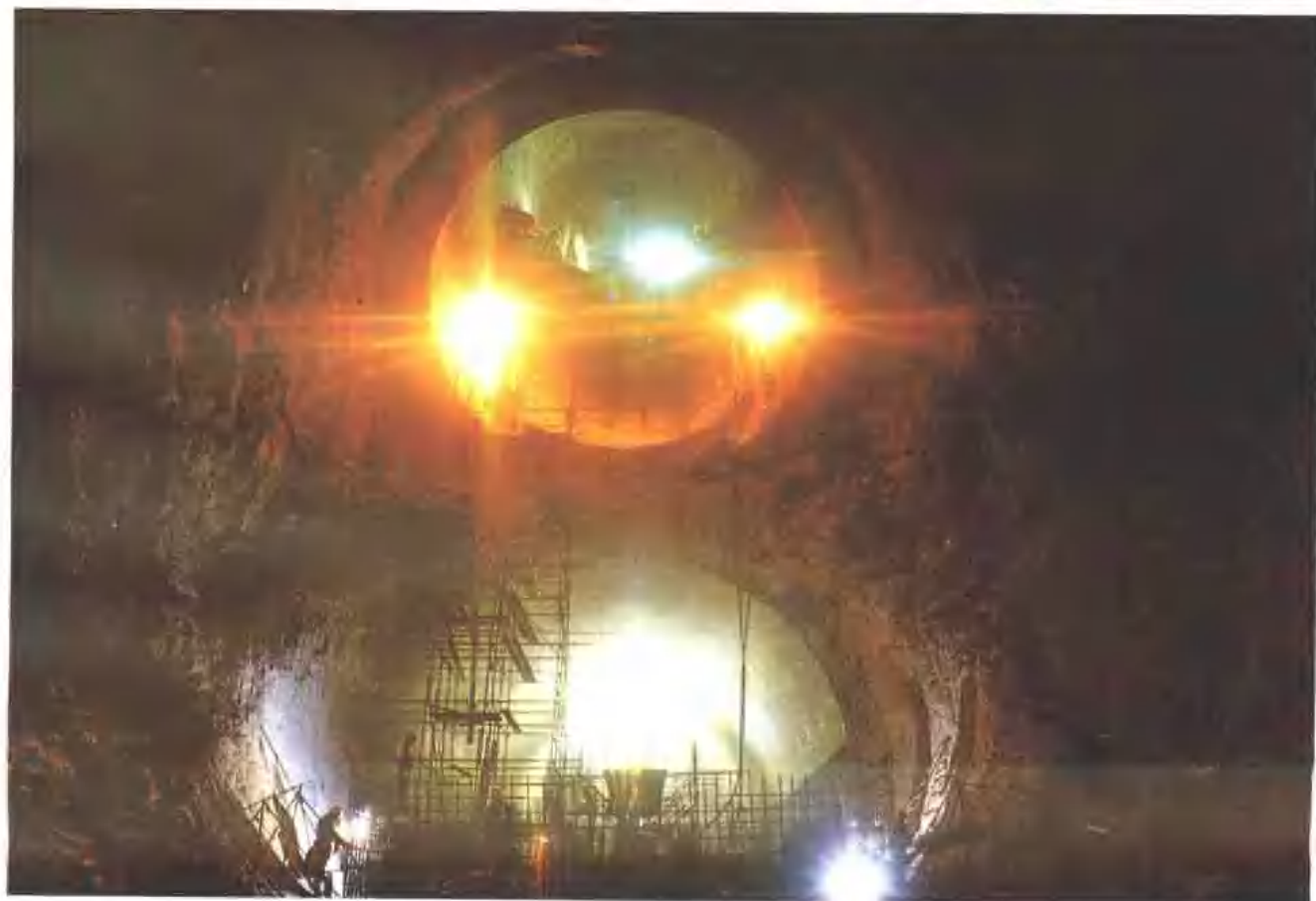
孔板洞“龙抬头”段施工
