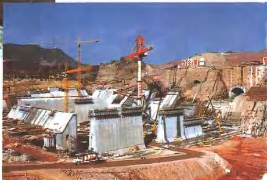
出口消力塘施工全景
