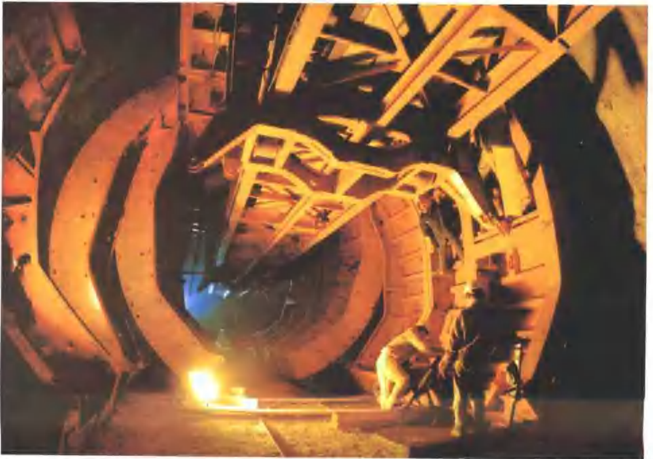
应用钢模台车进行排沙洞衬砌
