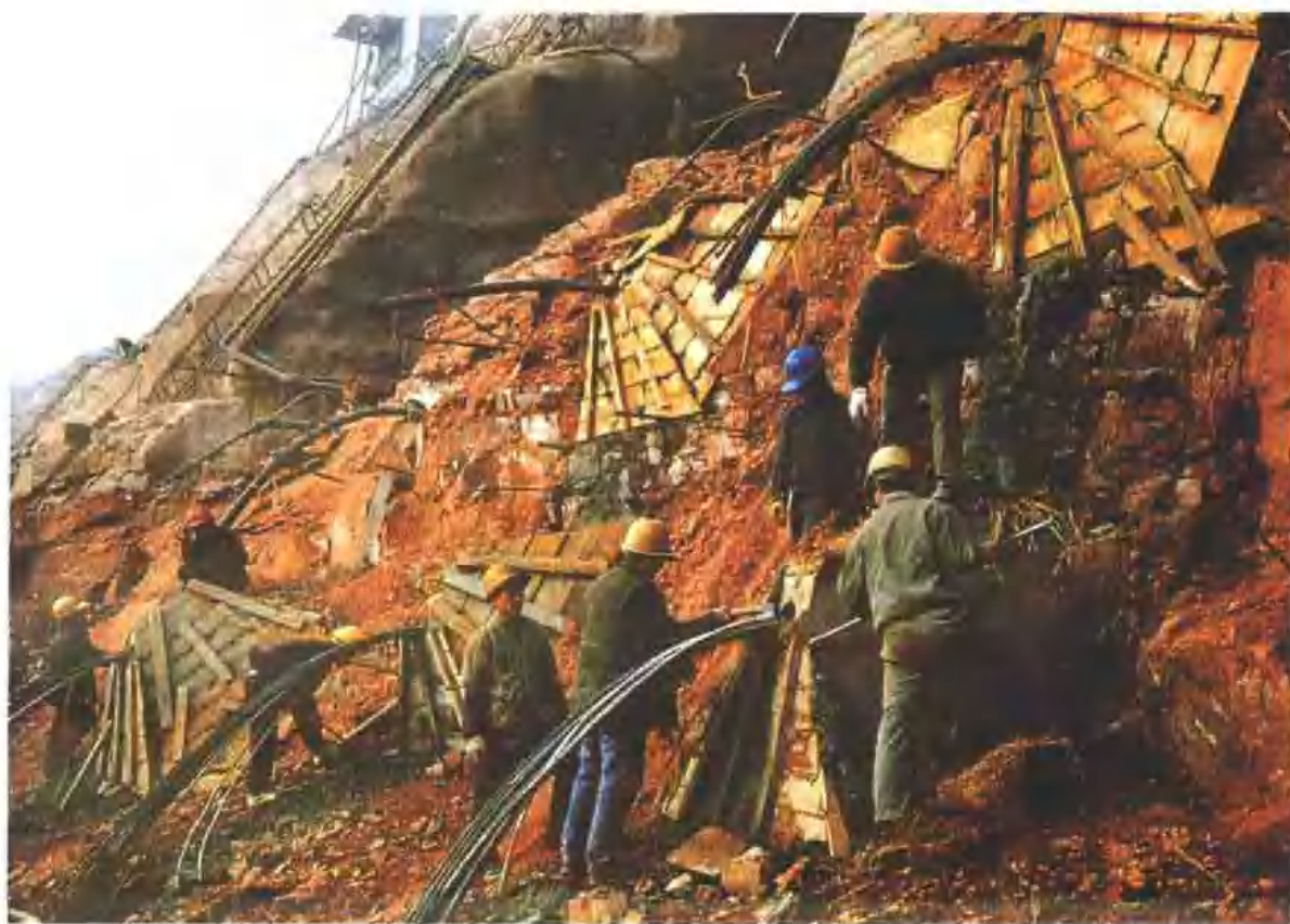
出水口边坡锚索安装
