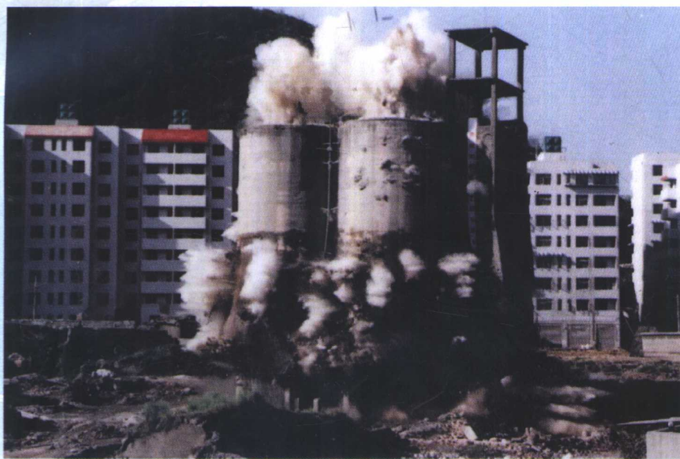
采用水压爆破技术拆除大容量水泥储仓群
