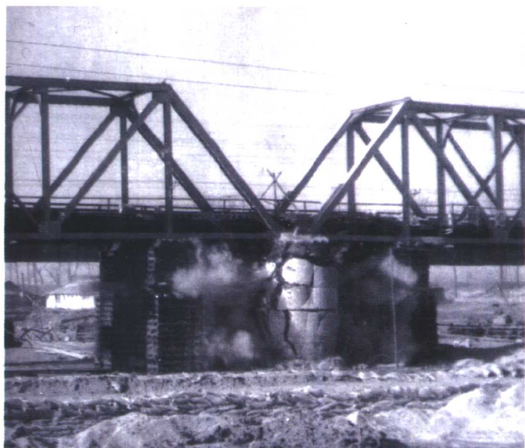
在运营复线爆破拆除旧桥墩
