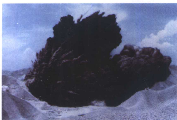
深孔爆破起爆瞬间(远景)
