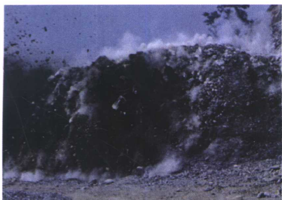
深孔爆破起爆瞬间(近景)
