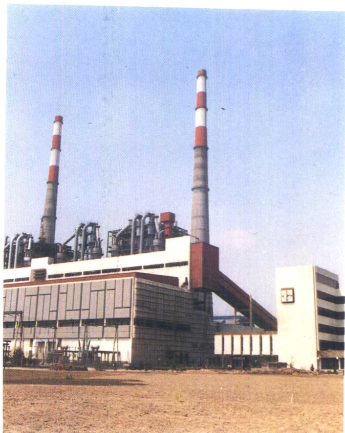
我厂制造的30万千瓦电站锅炉在石洞口电厂安全运行
