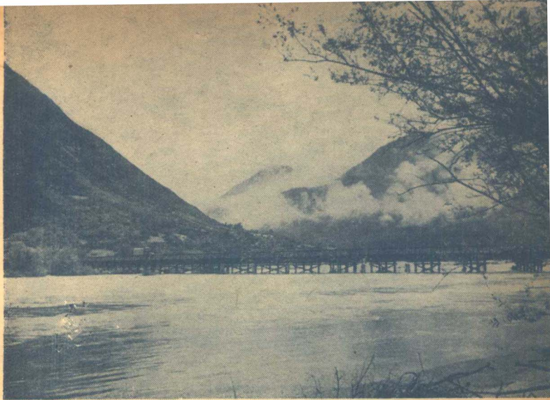
17. 康藏公路上利用當地的資源架設了許多木結構的橋， 它既符合工程要求，又節約了國家大量鋼材。這是康藏 公路上最長的木橋——卡達橋。 （任用昭攝）
