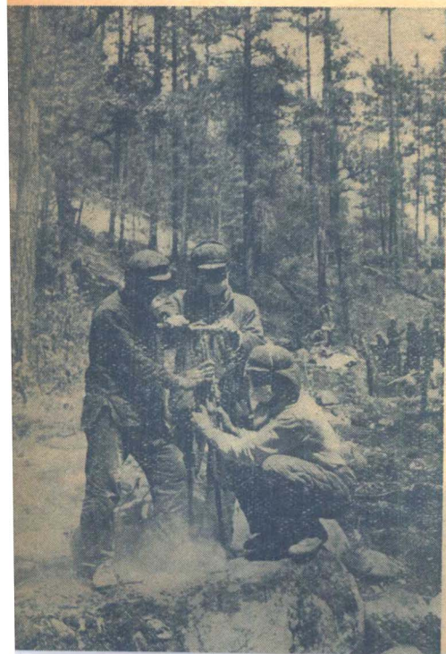
20. 工地上不斷從內地運 到新的機械。這是築 路工人正用“電門推 離合器”進行工作。
