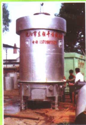
安装中的热风炉
