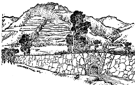
槽河岸上的石塊水泥大水坝
