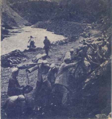
康藏公路經過許多流沙地區。圖為在流沙地區築路情形。
