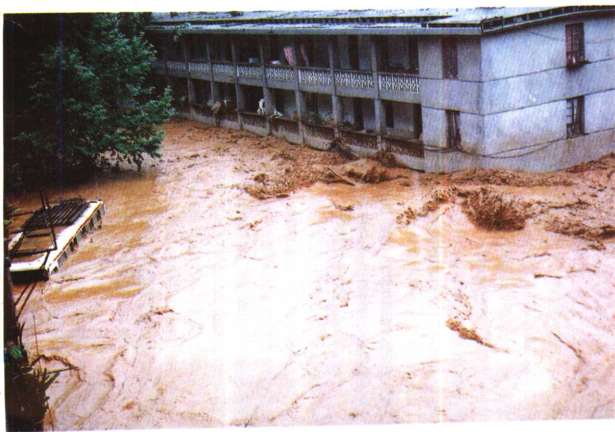
洪水袭击水城发电厂家属区情景
