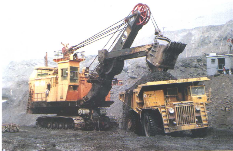
挖掘机装汽车现场
