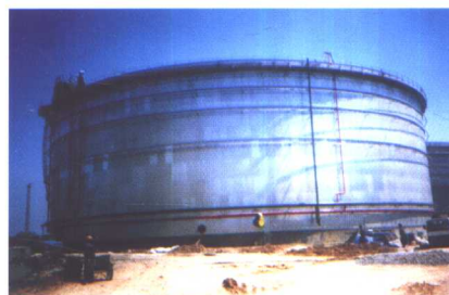
大连西太平洋有限公司油罐群 (1999-2000年施工)
