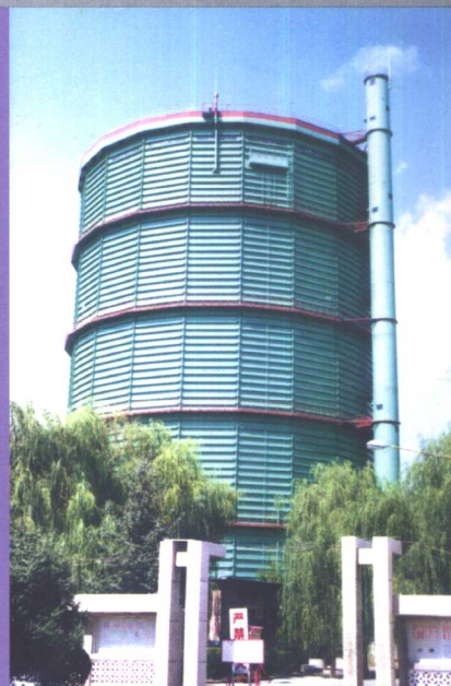
包头市煤气总公司5万 m^3 干湿 气柜施工的材料运用。
