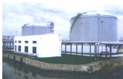
美孚(太仓)石油公司油罐群防腐施工(一)
