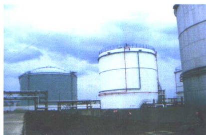
美孚(太仓)石油公司油罐群防腐施工(二)
