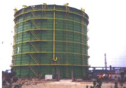
包头市煤气公司5万 m^3 威金斯式煤 气柜防腐安装工程。
