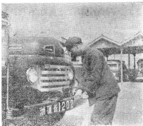
我用搖手柄空搖發動機几轉，使機件滑潤。
