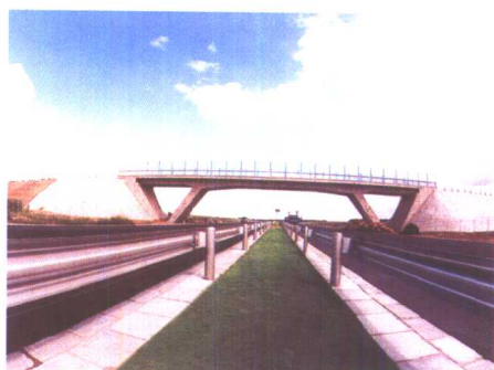
在我省首次采用斜腿刚构桥梁技术
