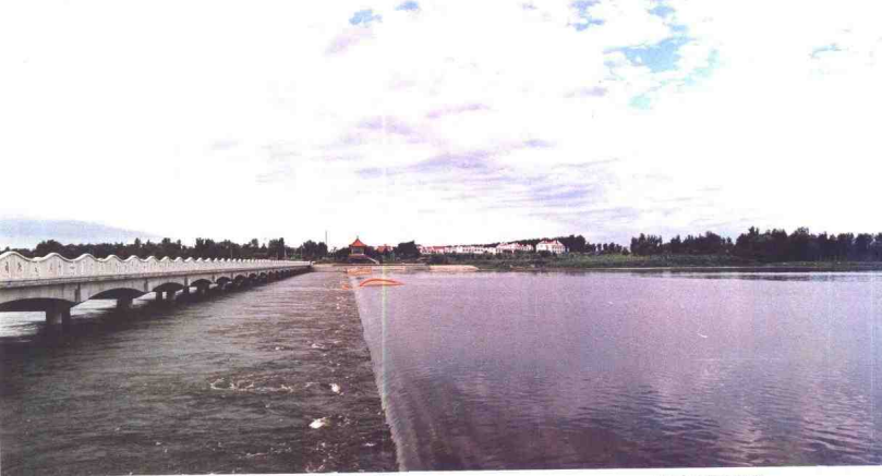
潮白河河南村闸桥
