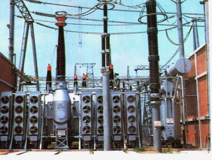
◀ 沈阳变压器厂制造的 500千伏25万千伏安有载 调压变压器
