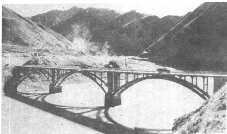
通天河上的公路桥
