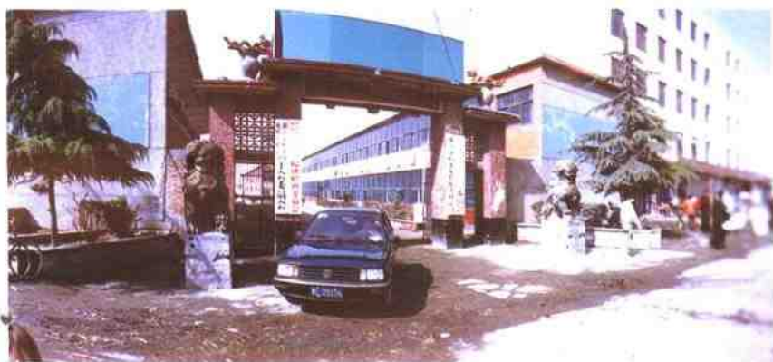
漯河金柱水泥股份有限公司 景
