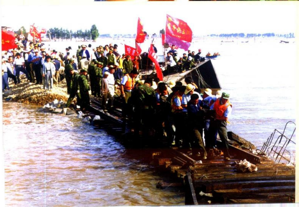
铁路应急抢修队伍 抢建被洪水冲毁的铁路 线路
